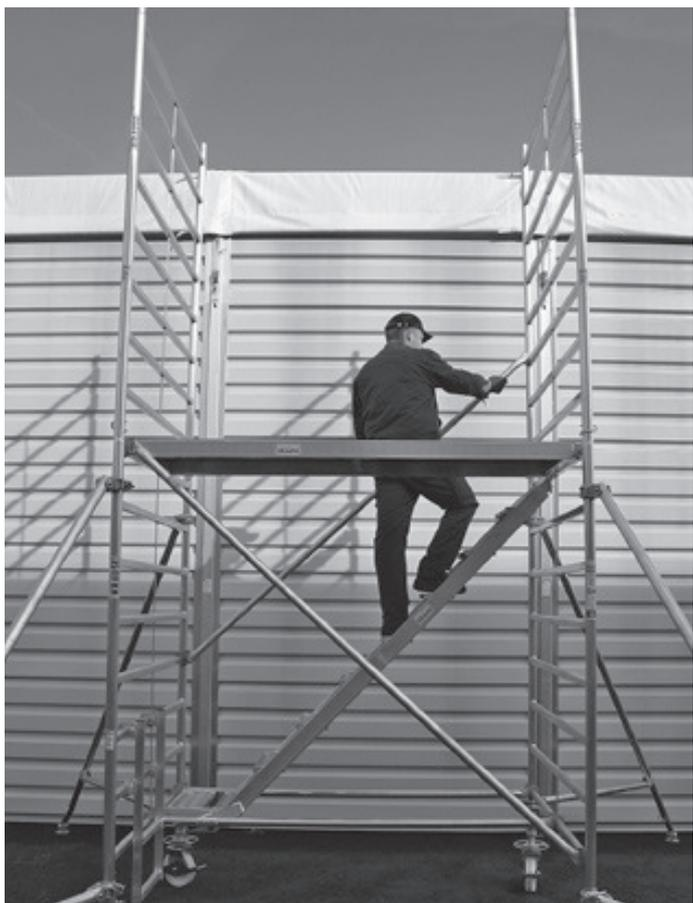
Lassen Sie sich eine Diagonalstrebe anreichen und setzen Sie diese am unteren Ende der Treppe in die vierte Sprosse von unten und oben in die dritte Sprosse des oberen Rahmens ein.
