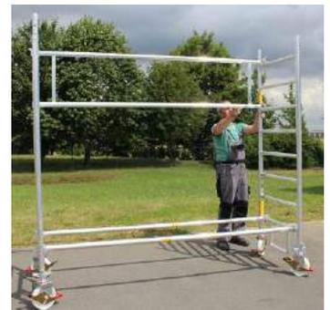
Die Platzierung des zweiten **Seitenschutz doppelt (2327)** erfolgt ebenfalls in der obersten Sprosse des **Vertikalrahmens (5321)** direkt an der Innenseite der **Diagonale**.
