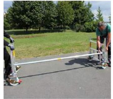
**Tipp !!!** Platzieren Sie die **Längsriegel (2340)** nicht direkt neben dem Ständerrohr des **Anfangs-Vertikalrahmens (5326)**, sondern in einem Abstand von ca. 5 cm. Dies erleichtert später das Einhängen der **Diagonalen (2337)**.
