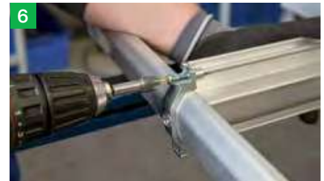
6 Kurze Schraube (5,5 x 25 mm) montieren
