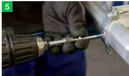
5 Neue Stufe und Stufenhalter wieder einsetzen, lange Schraube montieren (Schraube mit blauer Klebesicherung und Sperrverzahnung. Anzugsdrehmoment ca. 10 Nm)
