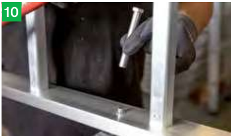
10 Fertig montierte Sicherungsscheibe
