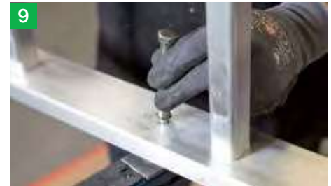
9 Sicherungsscheibe mit Rohr und Schlosserhammer aufbringen
